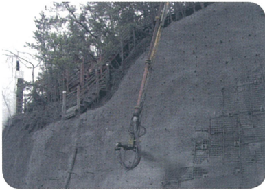
Wire Mesh 보강 슛크리트
